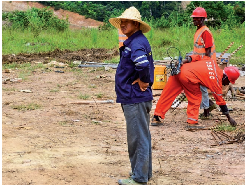
Neubau einer Straße von Dolisie nach Doumanga (DR Kongo) unter chinesischer Aufsicht, Foto: Jbdodane/Flickr.com
