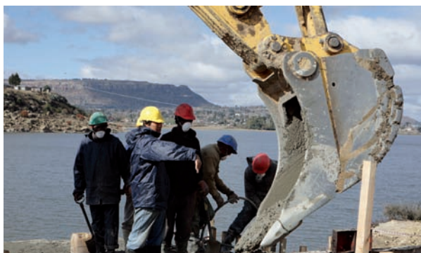
Arbeiten an einem Wasserauffangbecken in Lesotho, Foto: John Hogg/World Bank/Flickr.com
